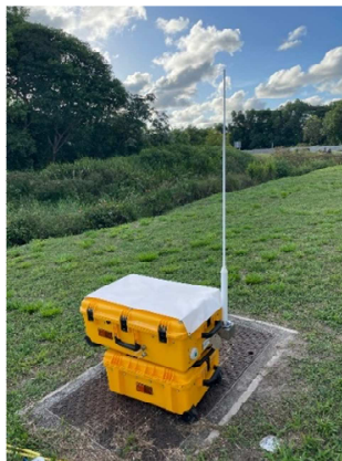
Figure 5 : SPM mobile installé en champ proche
