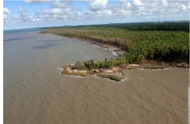
Figure 36 : Battures et mangroves ©2019 ESA-CNES-ARIANESPACE/Optique Vidéo du CSG – P BAUON
